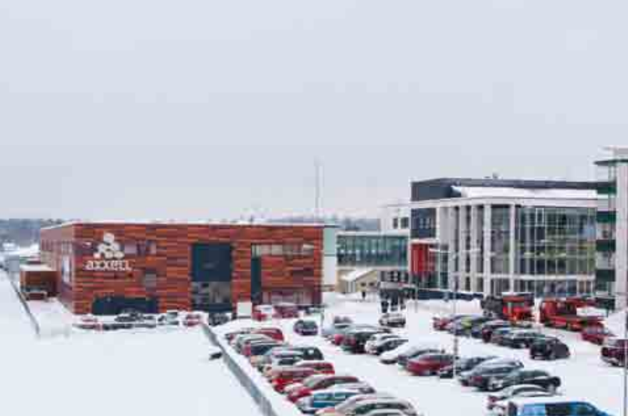
I "vita huset" till höger finns frisörs- och kökslinjerna tillsammans med köket och matsalen, medan mekaniker-, metall-, bygg-, snickeri-, vvs- och starkströmslinjerna huserar i den varmröda byggnaden på andra sidan Bangatan. Byggnaderna är ihopkopplade med en inglasad viadukt, där det populära caféet har sittplatser.
