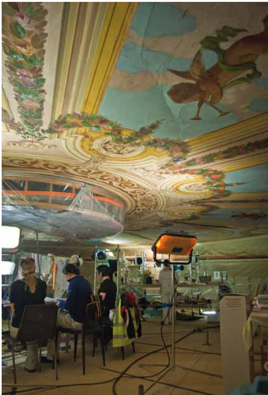
Renoveringen av teatersalongens takmålning är ett pietetsfyllt arbete som kräver stort tålamod.
